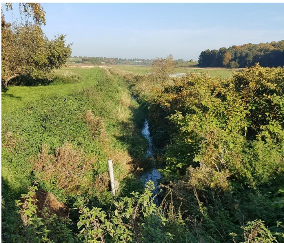
Figur 6-17 Græse Å set fra Krogenlundvej over den tidligere Kedelsø i retning mod Lyngø
