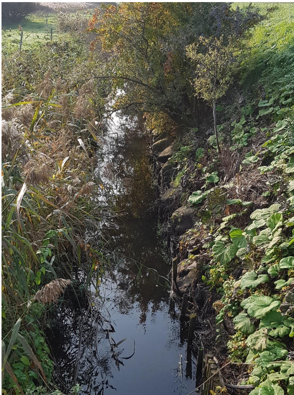
Figur 6-30 Jonstrup Å langs Knardrupvej lige før sammenløbet med Bunds Å. Denne strækning er kanalagtig og med ringe fald. Vejen ligger på billedet på højre side, som er forstærket med faskiner og udlagte sten.
