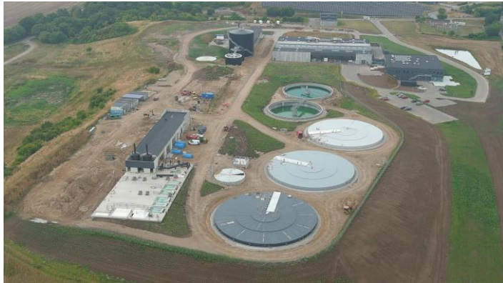
Assens Nytt Renseanlæg (modelfoto), Under opførsel Forventet færdig i 2023
