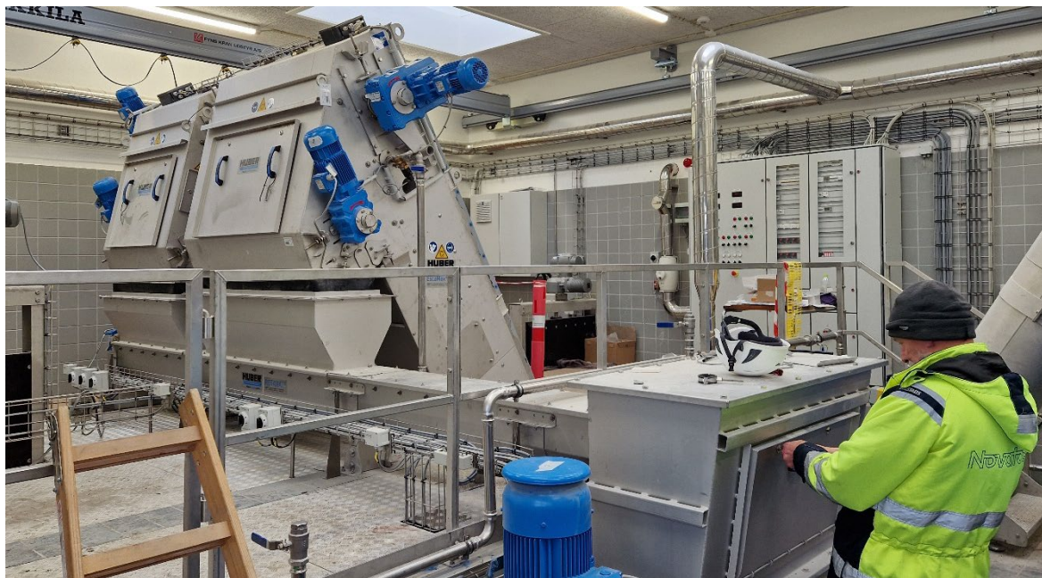
Figur 46: Det nye ristehus på Lillerød Renseanlæg.
